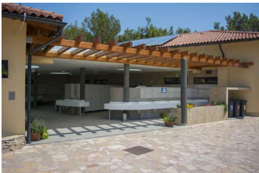
Slika 10. Primjer vanjskog sanitarnog bloka
