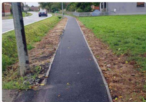
IZGRAĐEN NOGOSTUP U ULICI MATE LOVRAKA
