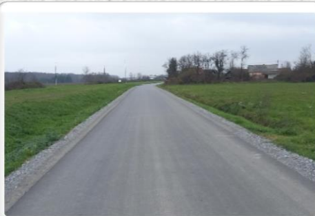
MODERNIZACIJA CESTE PREMA DJEČJEM VRTIĆU TRATINČICA
