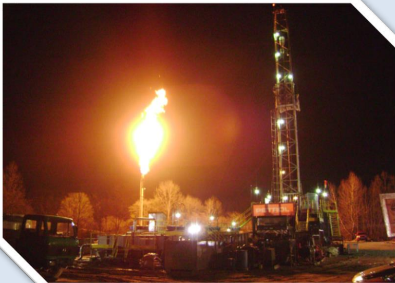
Podzemno skladište plina – nastavak radova
