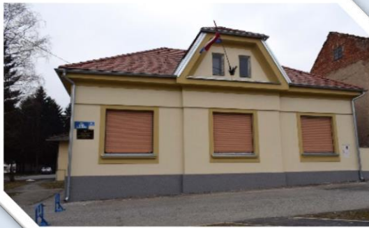
Obnova braniteljske zgrade
