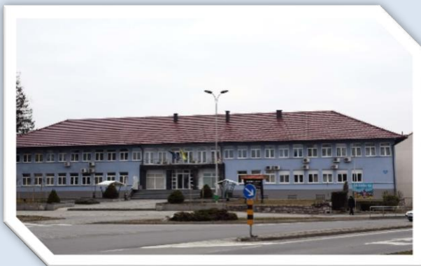
Obnova krovišta na zgradi gradske uprave
