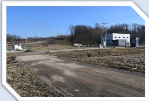
Asfaltiranje ceste prema deponiji iz sredstava EU
