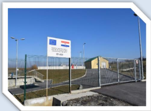
Uređaj za pročišćavanje otpadnih voda sufinanciran iz predpristupnog fonda EU – IPARD
