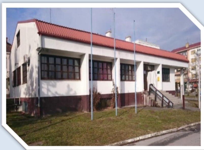
Energetska obnova zgrade Kolodvorska 2
