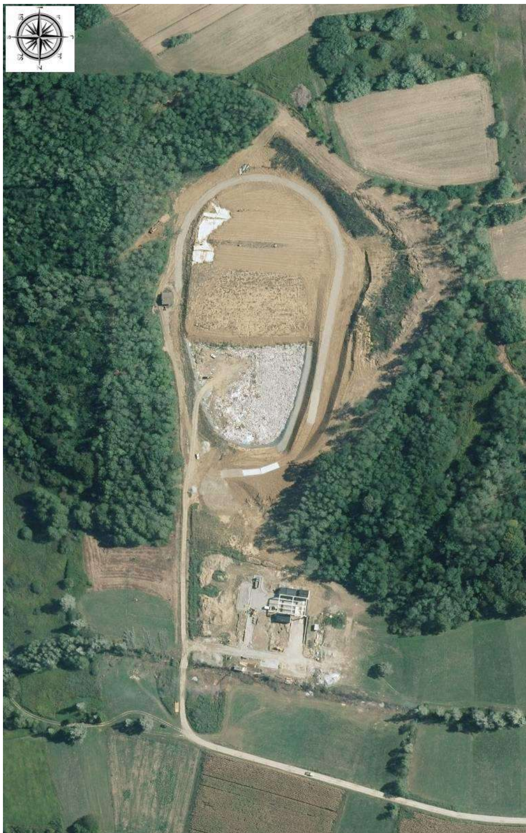
Slika 5.1./4. Ortofoto snimak odlagališta Prdavac visine pogleda 50 metara, M1:1786, lokacija u tijeku sanacije i izgradnje reciklažnog dvorišta
